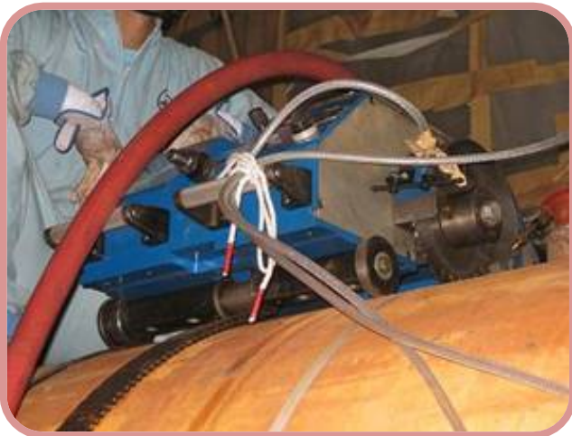
オービタルパイプ切断機による切断
