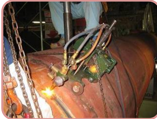
自動ガス切断器（自走式）による切断
