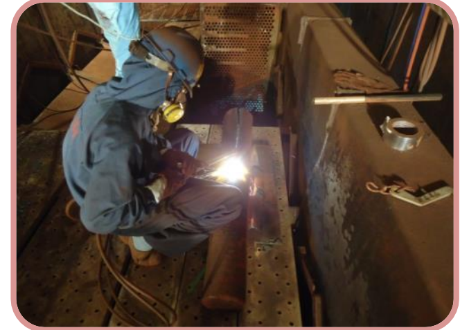
ガス切断器（手動）による切断
