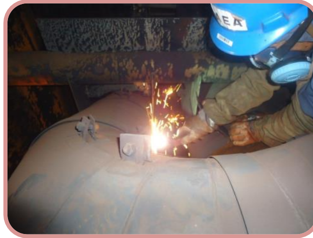
プラズマ溶断機による切断
